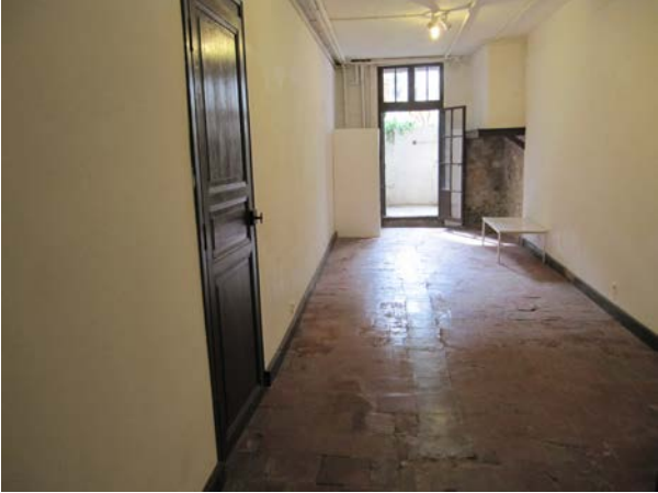
Hauteur de plafond : 2.80 m
