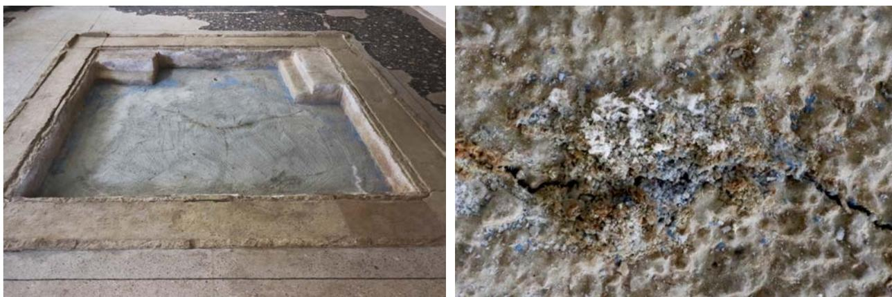
Mortier fissuré au centre du Frigidarium de la Villa Loupian, à l'endroit où est actuellement installé *Strati 2*.
